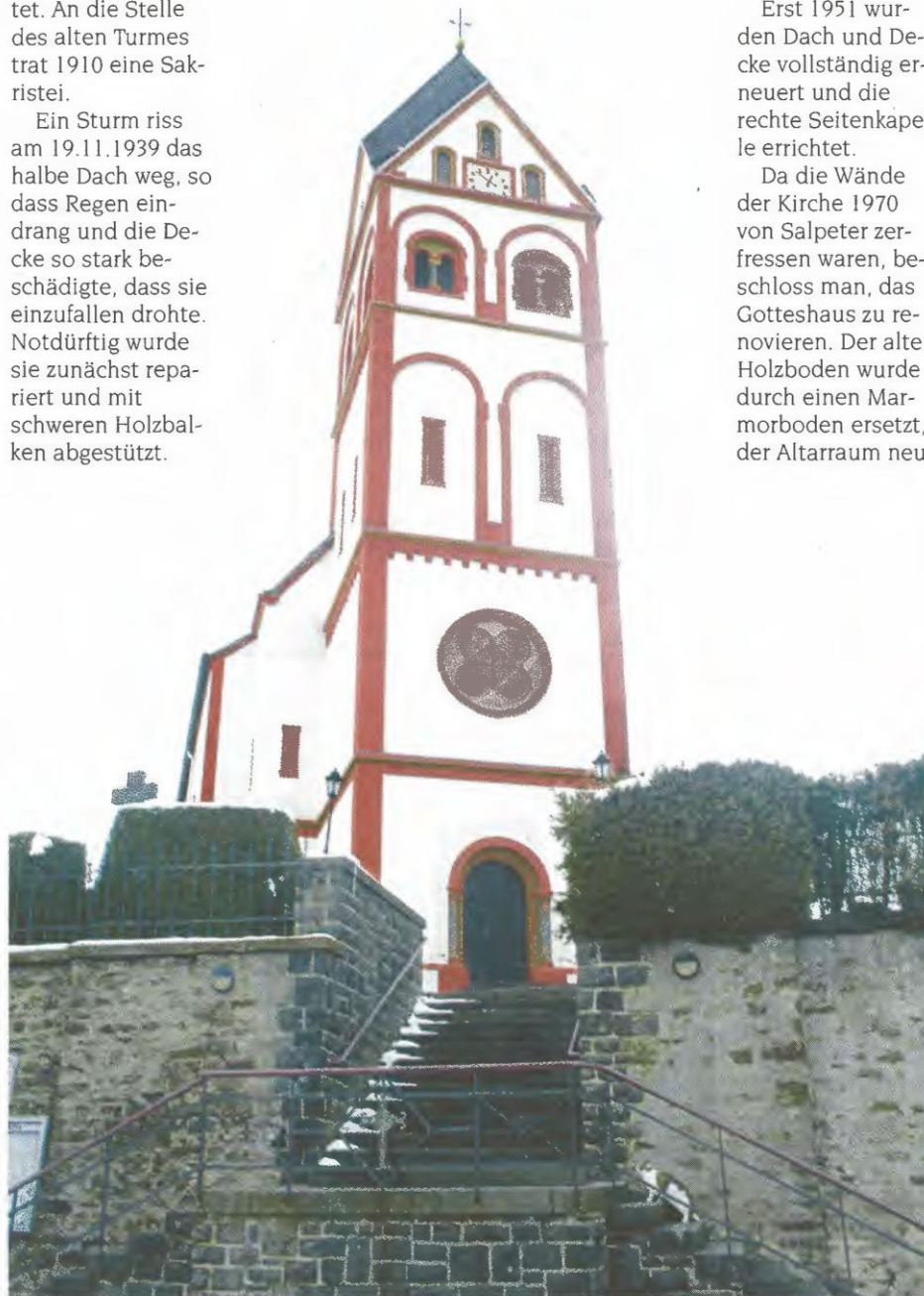
In einem ersten Bauabschnitt wurde der Turm der Pfarrkirche von Uersfeld renoviert.
