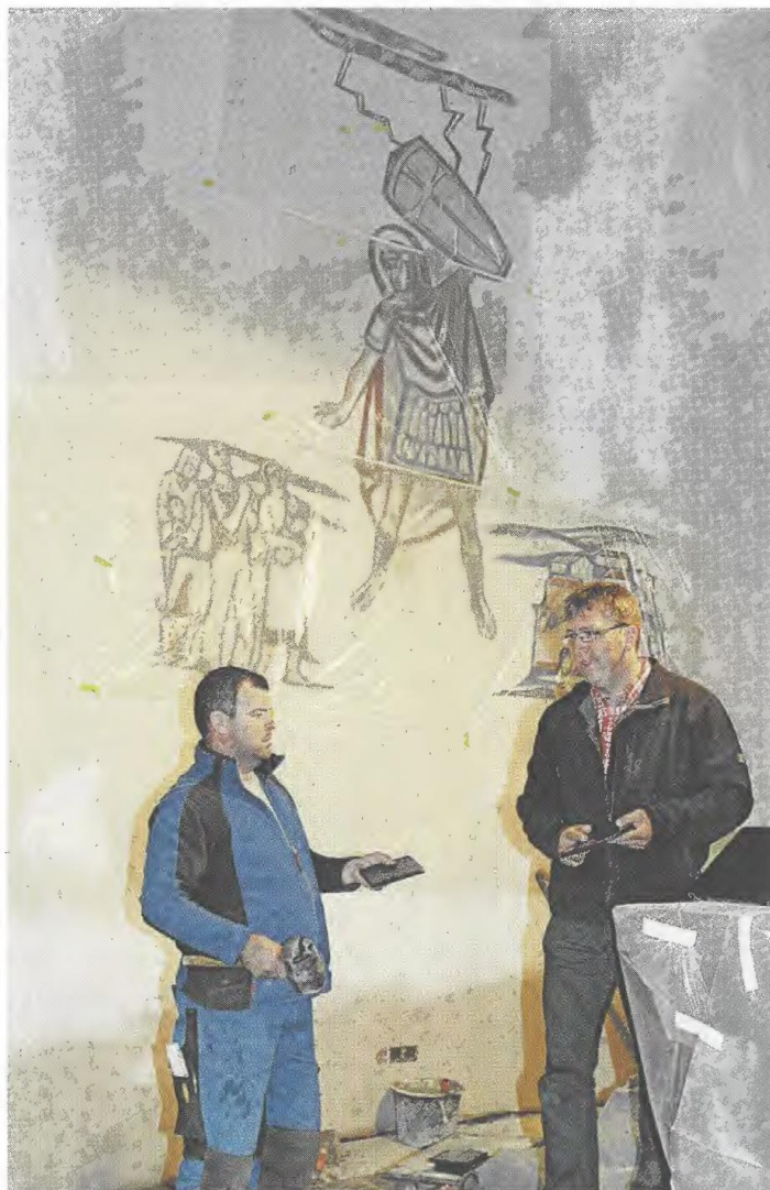
Steinmetz Muzafar Mavric (links) von der Firma Reinhold Laux aus Ulmen verlegt nach den Plänen des Architekten Stefan Bauer Fußbodenplatten in der St.-Donatus-Kapelle Zermüllen. TV-FOTO: BRIGITTE BETTSCHIEDER
